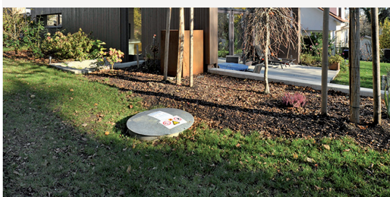
Unterirdisch eingelagerter Tank
