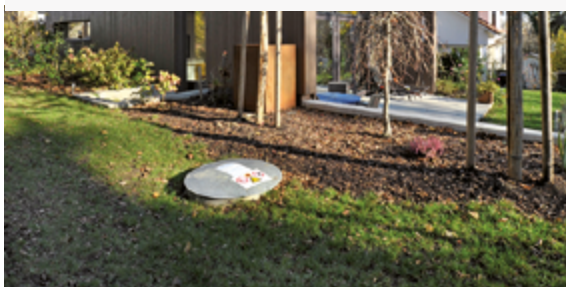
Unterirdisch eingelagerter Tank
